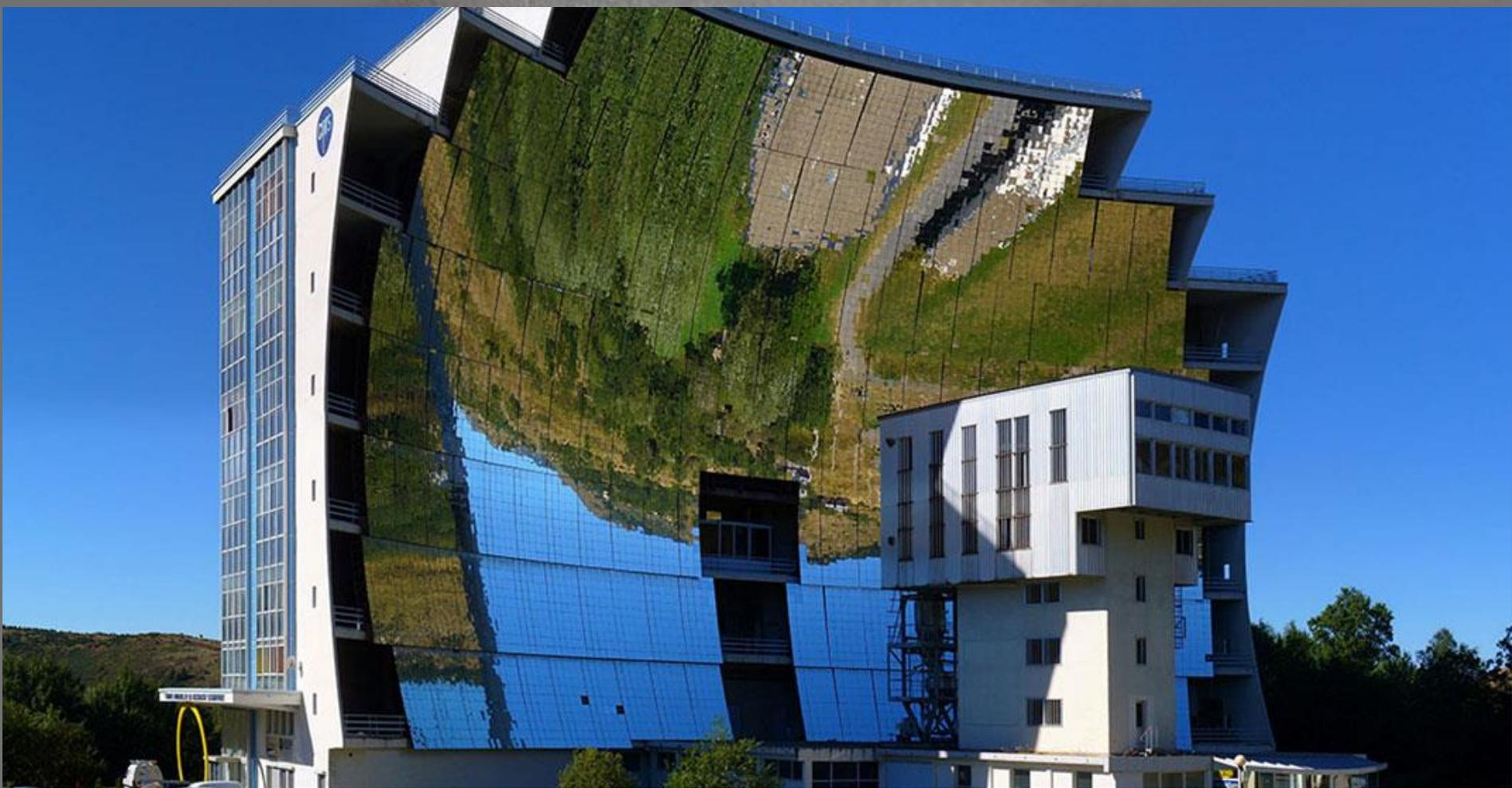
**Le four solaire d'Odeillo (Pyrénées), il permet d'obtenir des températures supérieures à 3 500°C, pour différentes recherches.**
